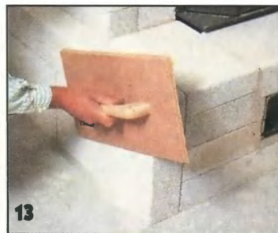
13 Когда клей высохнет, грубой теркой разглаживают неровности и снимают фаски на углах.
