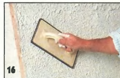
16 Когда штукатурка подсохнет (приблизительно через 10 мин), ее поверхности можно придать желаемую структуру.
