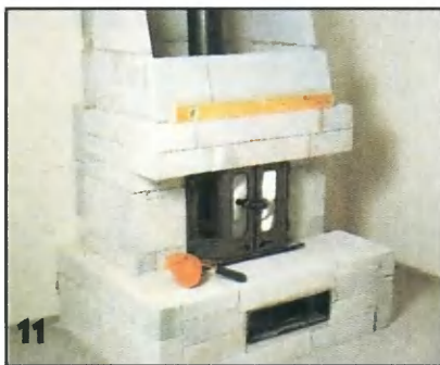
11 Газобетонные блоки толщиной 50 мм приклеивают к скошенным боковым стенкам фартука. Они образуют его лицевую стенку.
