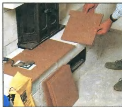
17 Полочку перед топкой и пол у камина облицовывают крупноформатными напольными плитками.
