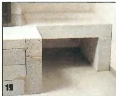
12 Из газобетонных блоков сооружают и скамеечку сбоку от камина. Высота ее соответствует высоте нижней кромки топки.
