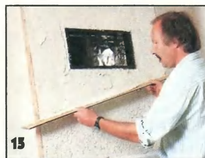
15 Затирают штукатурку, вода правилом по двум временно прикрепленным у краев рейкам-маякам.
