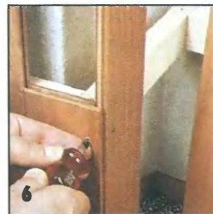
Крепление вагонки на шурупах.
