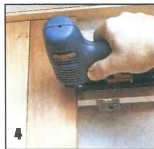
Скобки можно крепить и с помощью степлера, механического или электрического.
