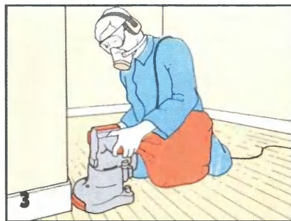
Обработку вдоль стен и в других недоступных для барабанной циклевочной машины местах ведут с помощью дисковой машины или ручной шлифовальной машинки.
